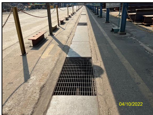
ภาพที่ 2.12 รางระบายน้ำฝนภายในพื้นที่โครงการ
