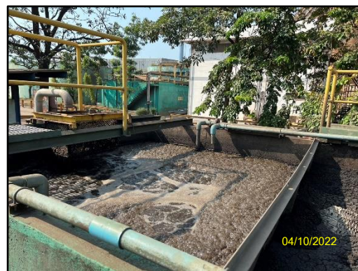
ภาพที่ 2.8 ระบบบำบัดน้ำเสียแบบเติมอากาศ
