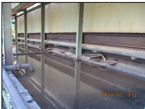
ภาพที่ 2.8 ระบบบำบัดน้ำเสียแบบเติมอากาศ
