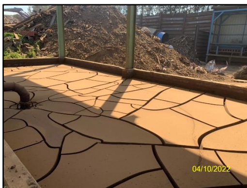
ภาพที่ 2.9 บ่อตากตะกอน (Sludge Drying Bed)
